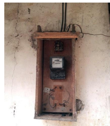
Figure 16: PL sans dispositifs de sécurité (disjoncteur)
