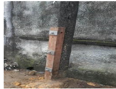
Figure 15: Poteau bois avec son support de renforcement
