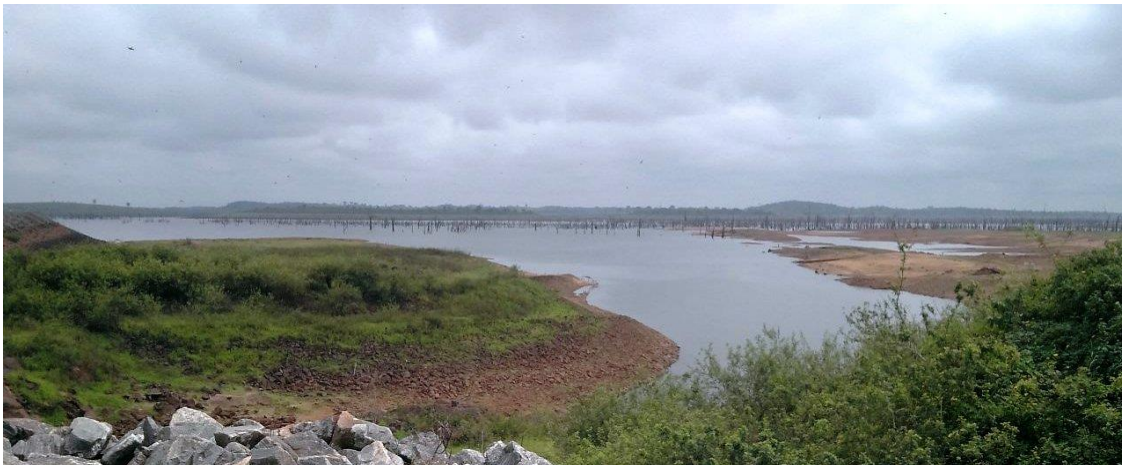
Figure 12: Assèchement du niveau d'eau dans le barrage réservoir de Mapé
